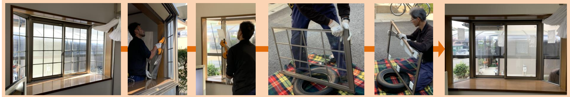
単板ガラス入りサッシのガラスを複層ガラスに交換。サッシの枠は既存のものを使うので、枠色はそのまま。部屋の雰囲気も変わりません*
