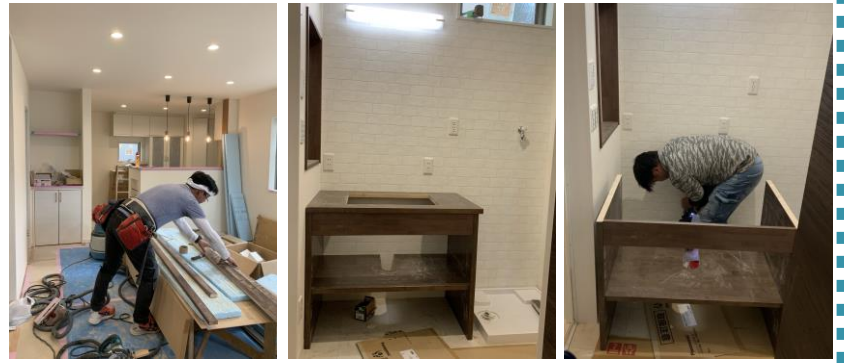
造作洗面台のボウルの位置に合せて配管工事を☆
