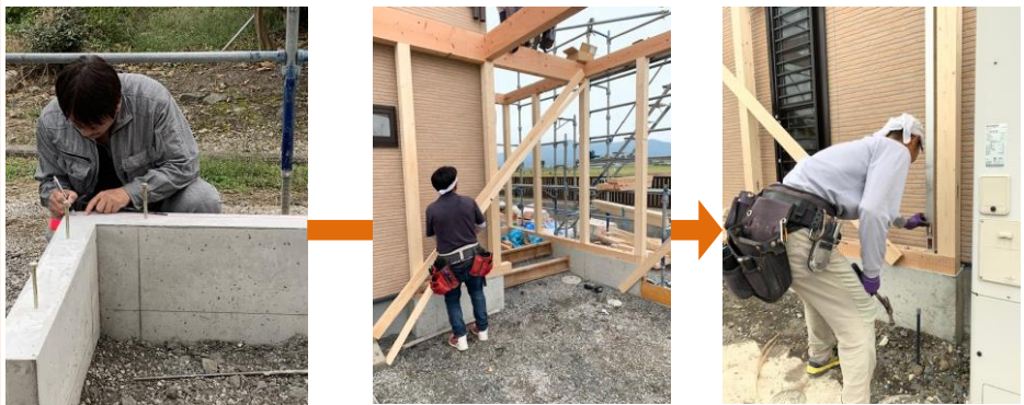
工事には正確さが重要。ミリ単位で下地の墨出しをして柱を建てていきます。
